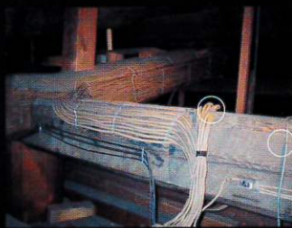
ネズミ・ハクビシンによる断線被害
